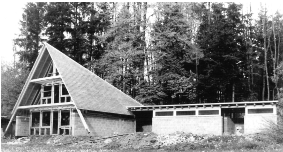
Rohbau des Landespfadfinderheimes Neuburg, Juli 1966
